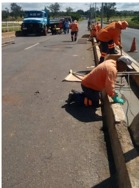
Execução das obras de recuperação
