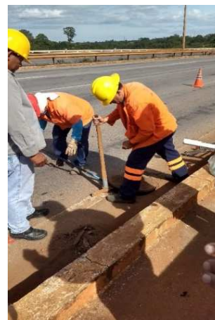
Desobstrução e troca dos drenos de águas pluviais
