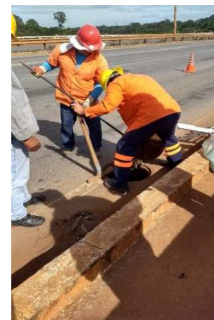
Desobstrução e troca dos drenos de águas pluviais
