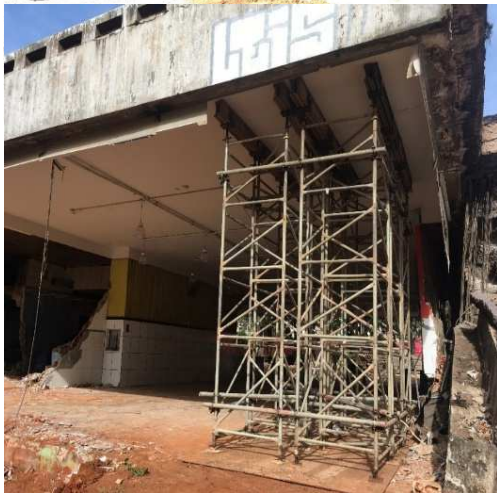
Execução de escoramento metálico temporário das lajes do tabuleiro
