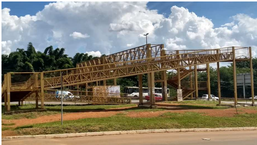
Situação atual das passarelas de pedestres
