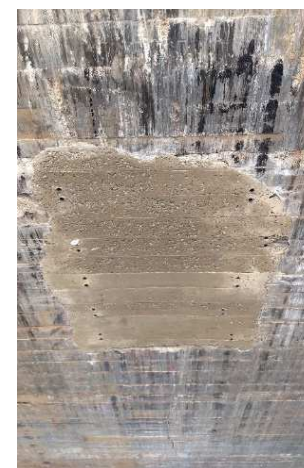
Recuperação das lajes inferiores da ponte
