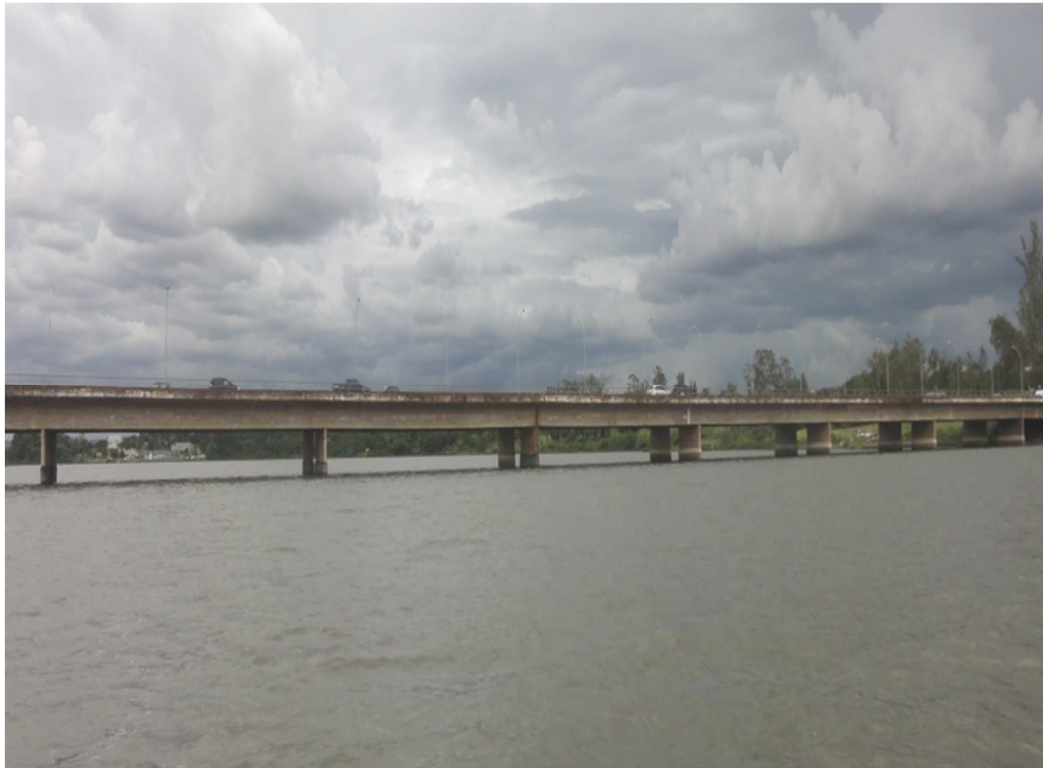
Ponte das Garças
