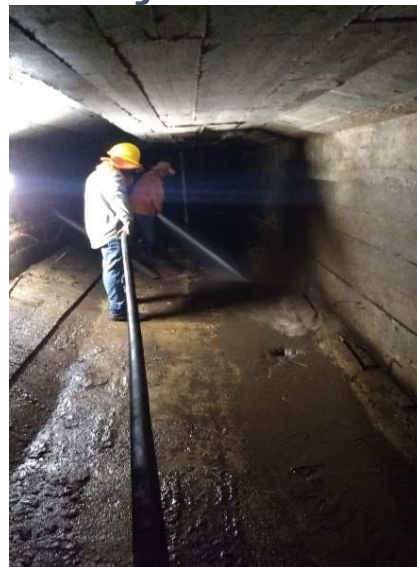
Retirada de sedimentos e limpeza no interior das galerias
