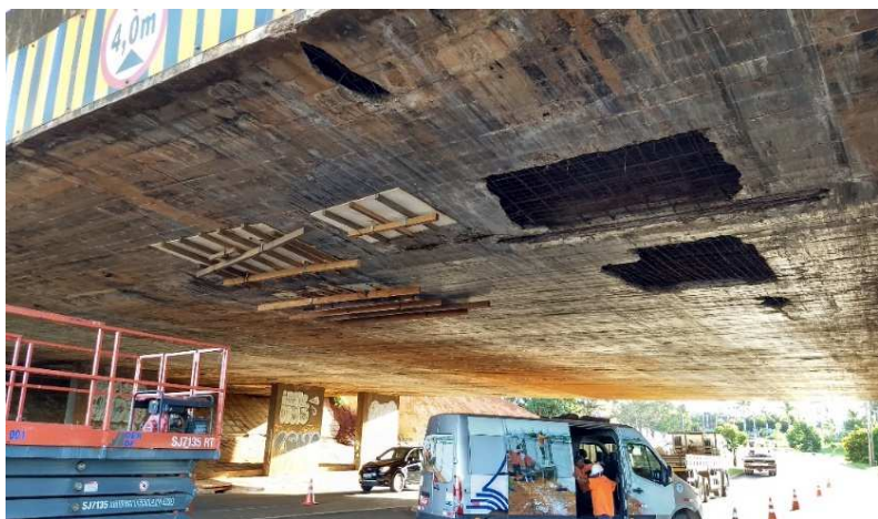
Recuperação das lajes inferiores da ponte
