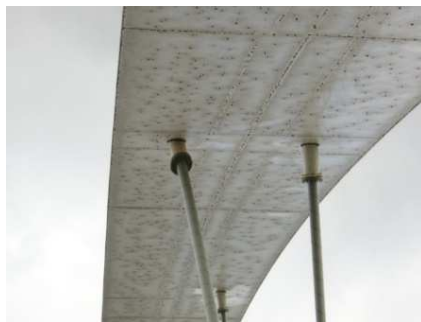
Situação atual da Ponte
