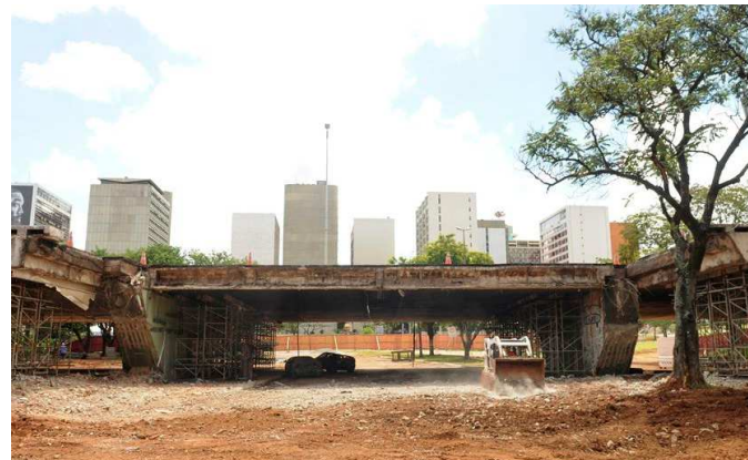
Demolição das vigas rompidas e retirada de entulho
