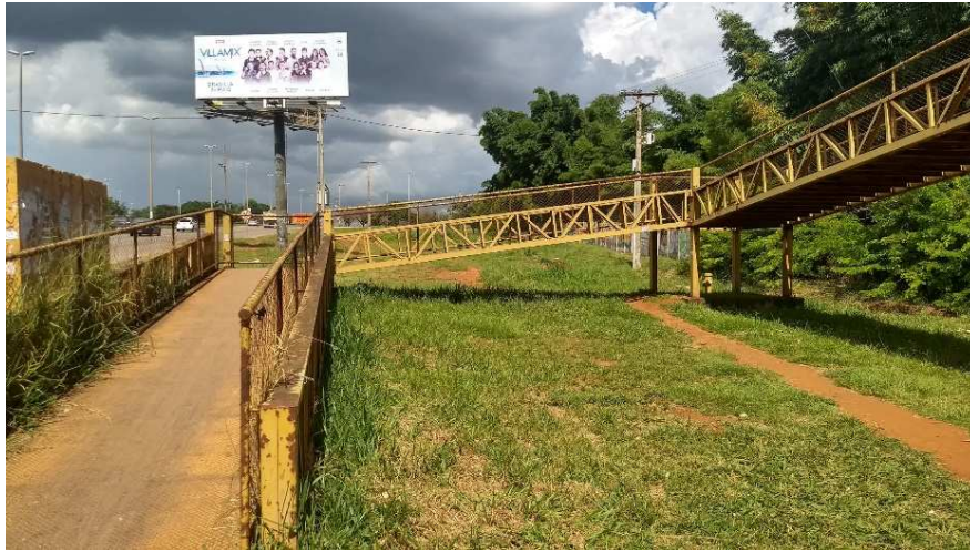
Situação atual das passarelas de pedestres
